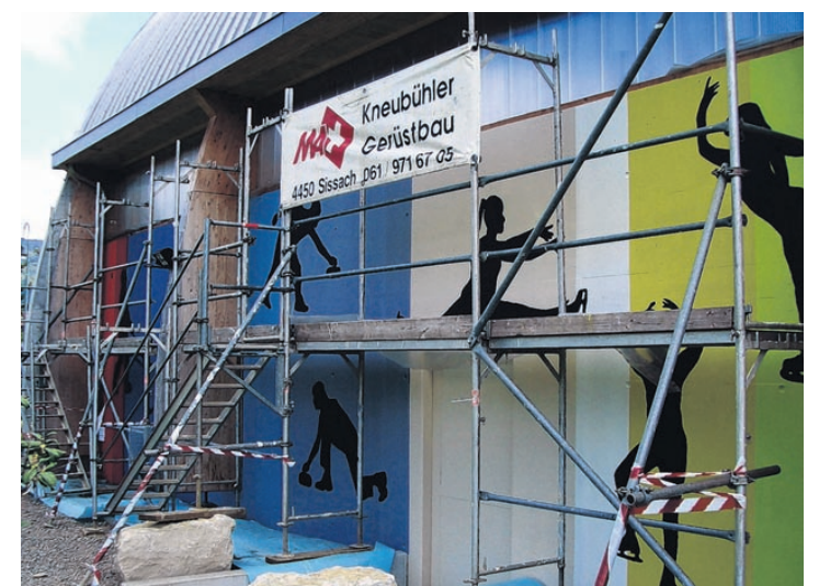
Das Gemälde hinter Gerüst: Ein zweiter Anstrich ist notwendig.
