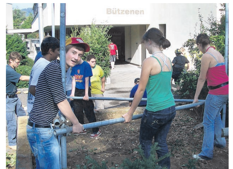
Shiprim stellt mit seiner Gruppe das Gerüst auf.
